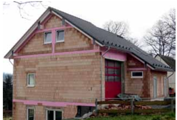
Mit Eigenleistung realisiert: Neubau Feuerwehrgerätehaus Gleidorf
