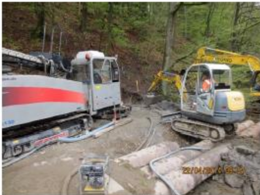
Zur Verlegung eines Abwasserkanals war eine 300 Meter lange Bohrung oberhalb der „Schwarzen Fabrik“ zwischen Oberkirchen und Inderlenne mit einem Durchmesser von 40 cm notwendig. Die Ausführung mit einem Spezialbohrgerät verlangte von den Firmen Tigges und König höchste Präzision.
