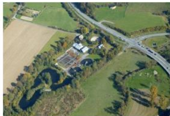
Zentrale Kläranlage des Ruhrverbands in Schmallenberg. Hier werden die Abwässer der Kernstadt, aus Grafschaft und des oberen Lennetals bis Nordenau/Nesselbach und auch des Sorpetales bis Rehsiepen gereinigt.
