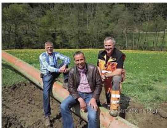
Winfried Schauerte, Wilhelm König (Fa. König, Westfeld) und Andreas Tigges (Fa. AT-Boretex, Schmallingenberg) nach erfolgreicher Bohrung zwischen Inderlenne und Oberkirchen. Im Hintergrund: Das in die Bohrung einzuziehende Rohr.
